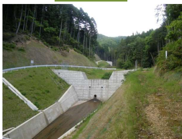
宮奥谷川砂防堰堤(京都府)
